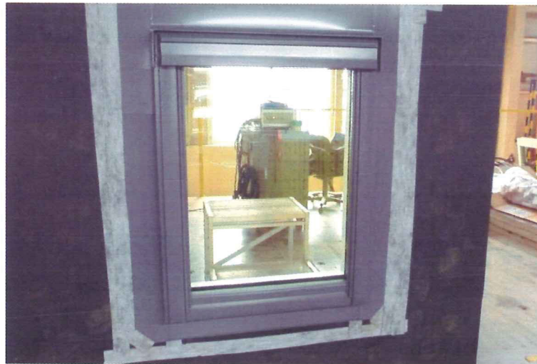
写真 3.1 試験体（屋外側）
